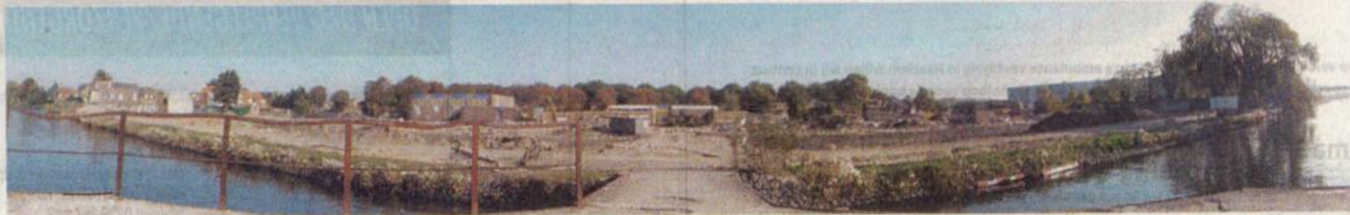
Notenlaan na de sloop.
